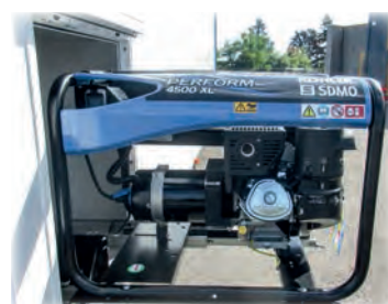
Integrierter Stromerzeuger (Diesel, Benzin, Gas)
